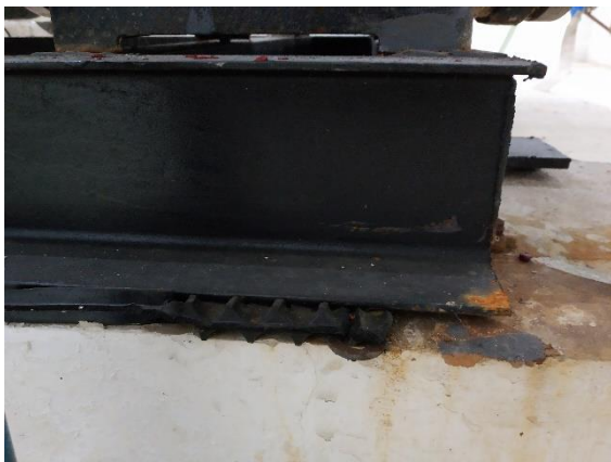
水泵房减振隔声底座
