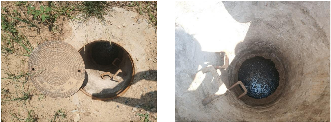
图 4.1-2 本项目化粪池现状图
